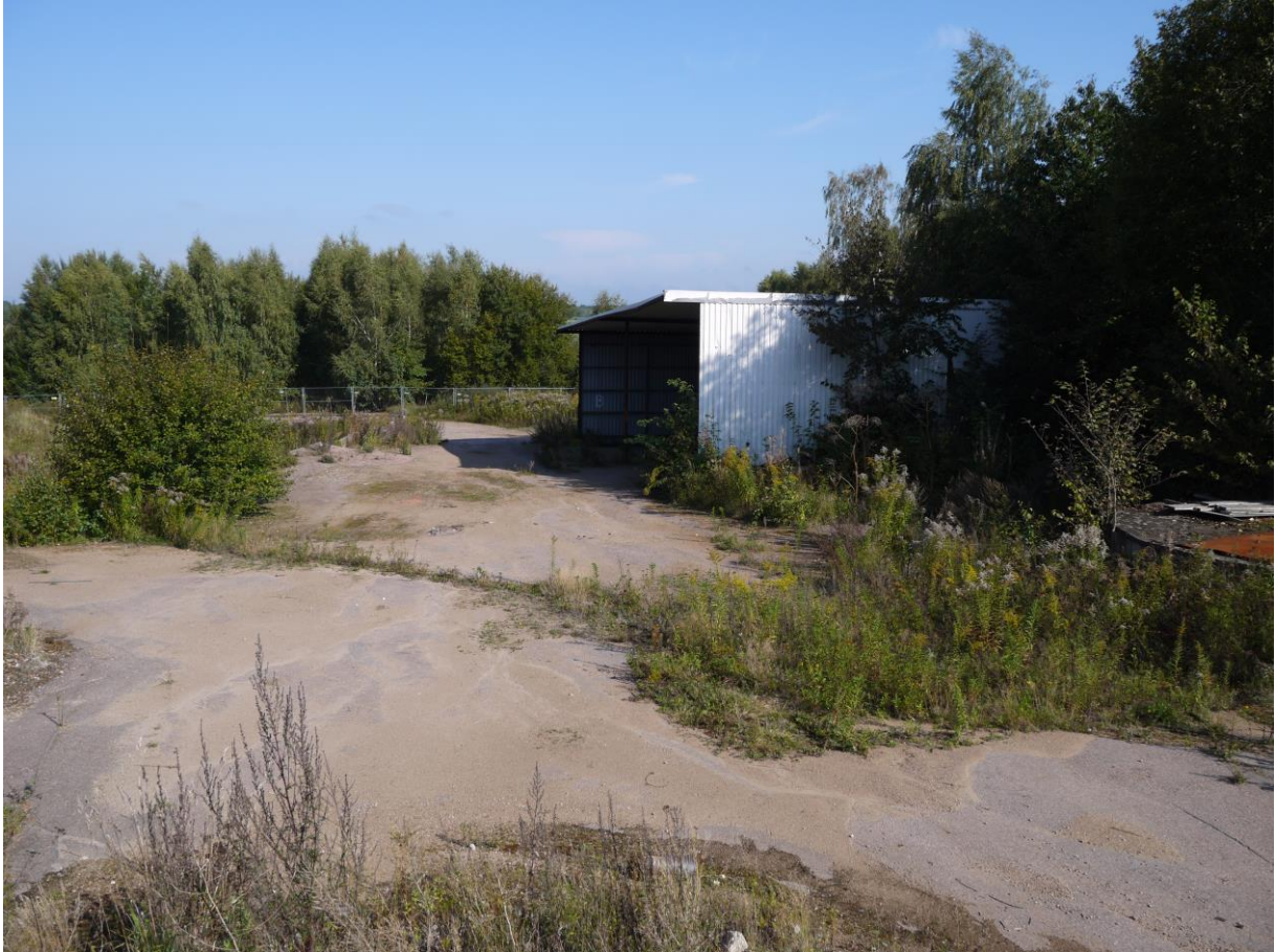
Figur 1. Foto av plåtskjul som ska rivas.
