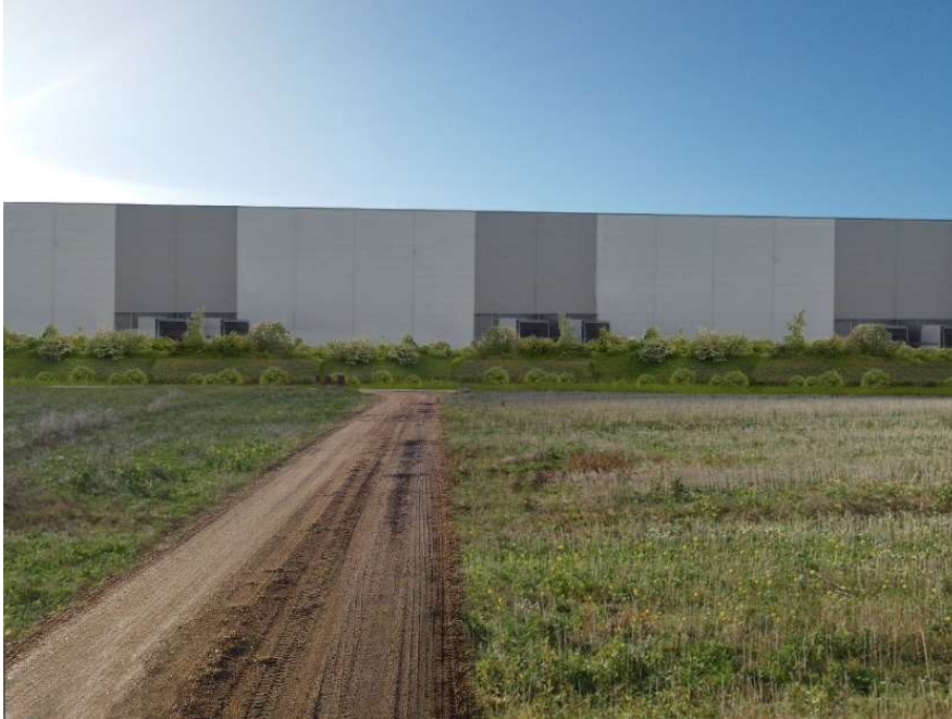
Figur 23. Vy 2, vy mot söder från befintlig fastighet i öster på befintlig grusväg. Den exploatering som berör fastigheten (se figuren) utgörs av den exploatering som redan idag är säkerställd i gällande detaljplan
