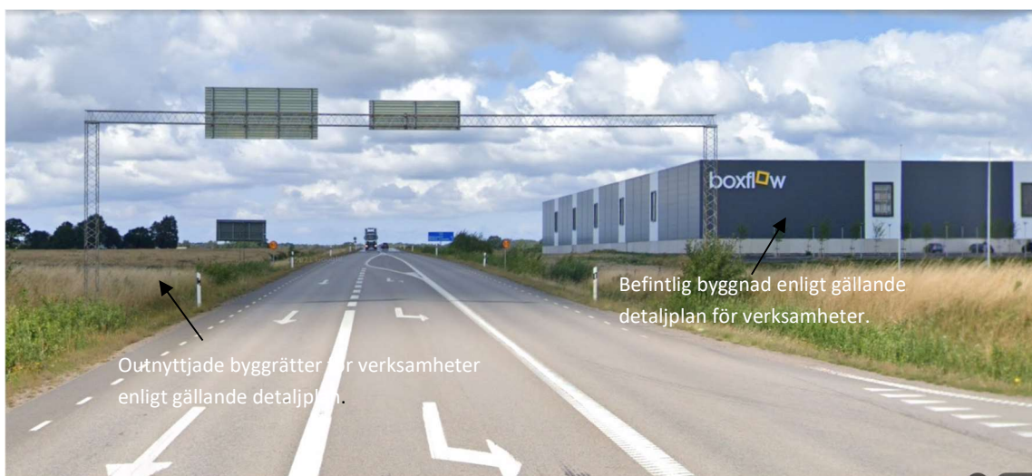
Figur 20. Befintlig byggnad öster om väg 13. Vy söder mot norr. Foto. Utklipp ur Google Earth.
